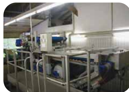
Prensa de banda de tamizado VA BFP-100 para deshidratación de fangos pútridos
