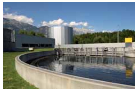
Planta de depuración de Innsbruck ▶
