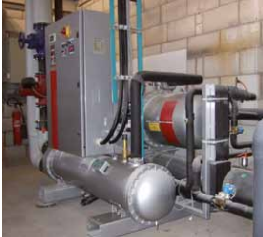
Die Großwärmepumpe ISWS 200 ER2 von Ochsner hilft der ALBEA Metalloberflächentechnik jährlich rund 73.000 Liter Heizöl zu sparen.
