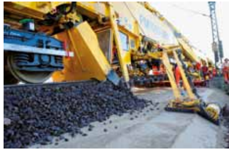
Die PM 1000 URM von Plasser & Theurer sorgt für einen höheren Anteil an wiederverwendetem Material zur Unterbausanieerung. The PM 1000 URM from Plasser & Theurer ensures a higher portion of recycled material for subgrade rehabilitation.
