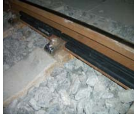
内外ゴム設置
