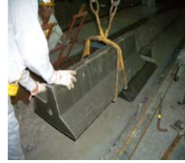
支承ブロック敷設
