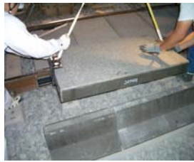
外部プレート敷設
