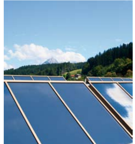
Machen aus dem Dach des MOGUNTIA-Werkes ein Wärmekraftwerk: die TiSUN-Großflächenkollektoren
