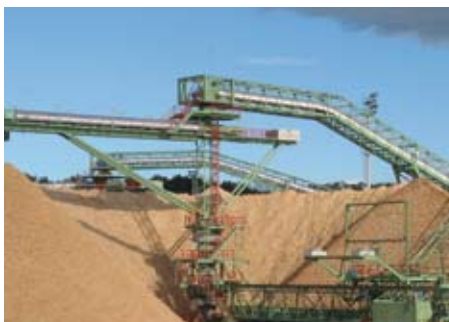
Hackschnitzellager und Rücknahmesystem Storage facilities for woodchips and fully automatic
