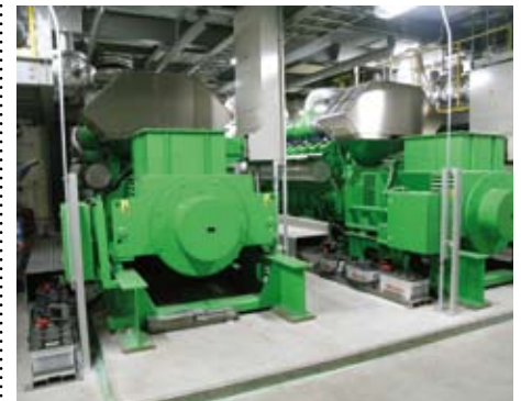
Jenbacher-Gasmotoren betreiben in Yamagata die größte Holzgasanlage Japans Jenbacher gas engines power Japan's largest wood gas power plant in Yamagata
