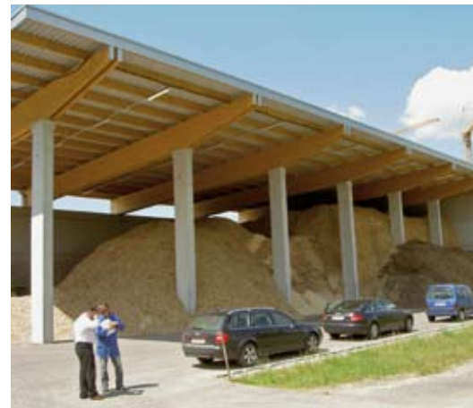
Das neue Biomasse-Heizwerk von Tirol Milch in Wörgl The new biomass heating plant at Tirol Milch in Wörgl
