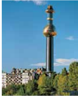
Die Elektroinstallationsarbeiten von Cegelec werden in Kürze abgeschlossen sein Cegelec will soon complete its electrical installation work
