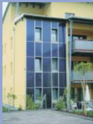
SIKO collectors adapt to the building. Die SIKO Kollektoren passen sich dem Gebäude an.
