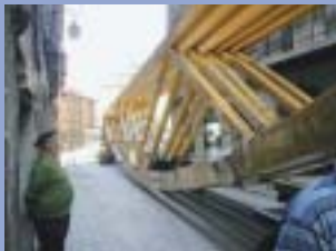
Transport of 36 m Freespan beams through spanish narrow alleys. Transport von 36 m Freespan-Trägern durch enge spanische Gassen.
