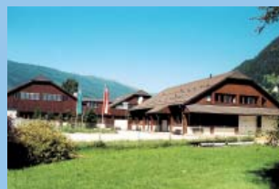
KACO facility, St. Michael i.Lg. Werksansicht KACO St. Michael i.Lg.
