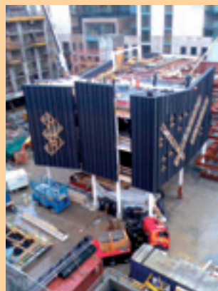
Millwork of steel structure for museum in Dublin, Ireland. Holzfertigteile auf Stahlskelett für Museum in Dublin, Ireland.
