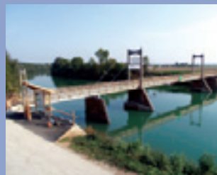
Longest round wood trussed bridge in Central Europe. Längste Rundholzbrücke Mitteleuropas.
