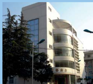
Equipment for hospitals. Ausstattung von Spitälern.
