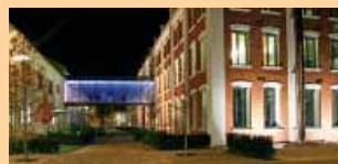
Distribution site Fronius International GmbH, Wels (Austria). Vertriebsstandort Fronius International GmbH, Wels (Austria).
