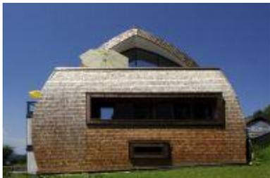
Die Firma Holzbau Unterrainer beschäftigt sich mit der Entwicklung, Produktion und Vermarktung von verleimten Brettsperrholz in gebogener Ausführung (Radiusplatten). Mit dieser innovativen Technik der Radiusplatte ist das Unternehmen das einzige europaweit, welches gebogene Brettsperrholz-Platten schnell und kosteneffizient herstellen kann.
