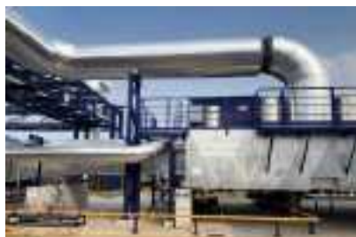
HVAC 废气收集系统 + 57600Nm 3 /H 三室 RTO, China
