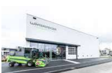
奥地利总部 | Headquarter in Austria
