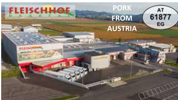
公司厂房 Company plant
