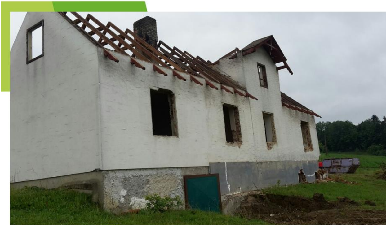
Foto: Erdbau Taucher
