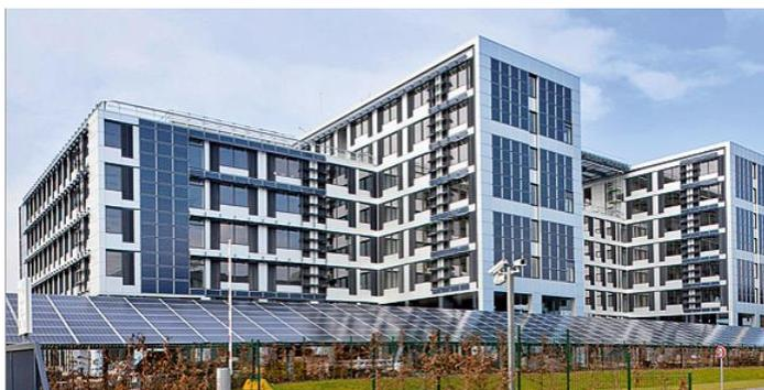
Green Office à Meudon, Photovoltaïque sur le toit et intégré à la façade pour créer un ombragement, photovoltaïque utilisé comme abri de véhicule – une performance maximum directement fournie aux consommateurs sur une surface réduite.
