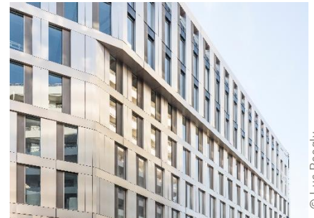
Le bâtiment Green Office® ENJOY de Baumschlager Eberle Architekten et SCAPE
