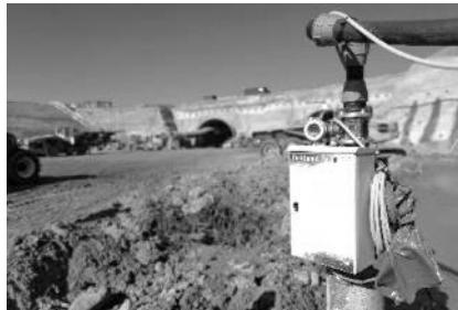
Sustav upravljanja za odvodnju podzemnih voda u tunelogradnji s više od 100 decentralizirao umreženih crnih stanica za bunare. Vizualizacija, upravljanje i obračun putem internetske platforme.
