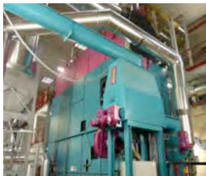
燃料供給及び灰回収システム
