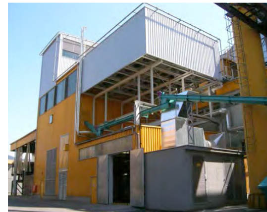
発電プラントとコージェネレーションシステム
