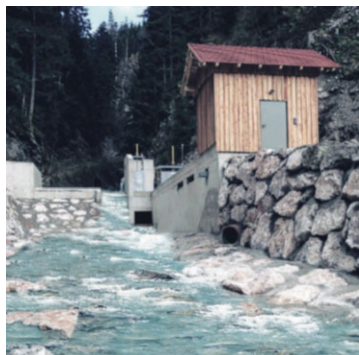
小水力発電設備
