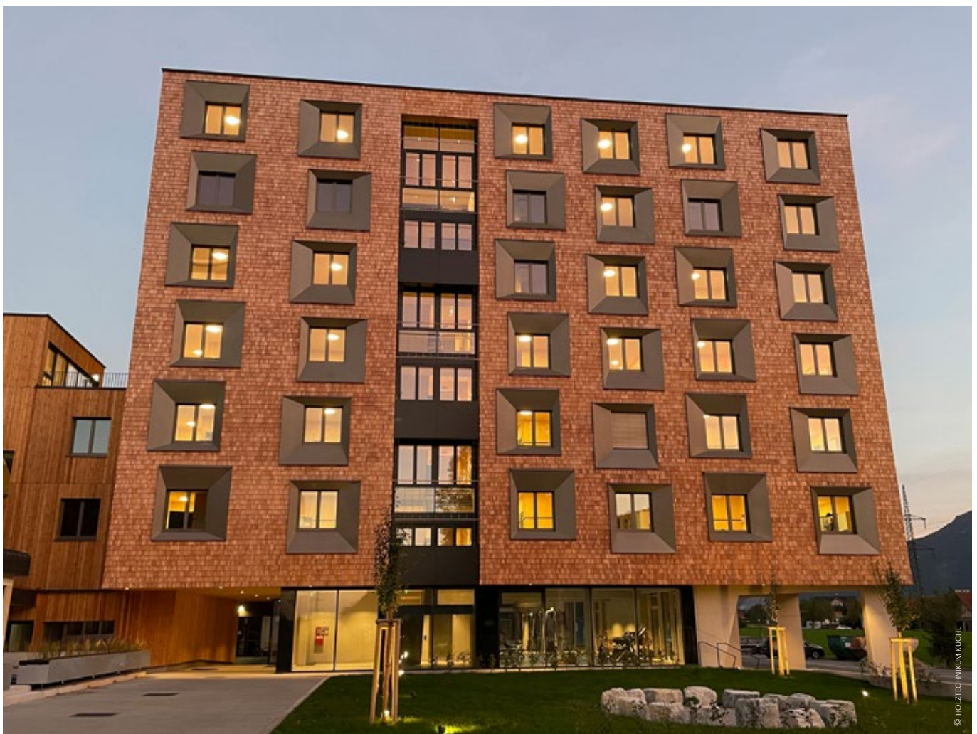
HTK-AUßEN-INTERNAT: EIN RICHTUNGSGEWEISENDES WAHRZEICHEN AUS HOLZ WURDE IN DER HOLZGEMEINDE KUCHL ERRICHTET. ANSTELLE DES BISHERIGEN „STAMMHAUSES“ DES HOLZTECHNIKUMS KUCHL AUS DEN 1950ER JAHREN ENTSTAND EUROPAS HÖCHSTES HOLZ-SCHÜLERWOHNHEIM – AUSGEFÜHRT IN HOLZ-MODULBAUWEISE UND MIT LÄRCHENSCHINDELN VERKLEIDET • HTK-EXTERNAL-BOARDING-HOUSE: A PIONEERING TIMBER LANDMARK HAS BEEN ERRECTED IN THE TIMBER COMMUNITY OF KUCHL INSTEAD OF THE PREVIOUS 'MAIN HOUSE' OF THE KUCHL TIMBER TECHNOLOGY CENTRE FROM THE 1950S, EUROPE'S TALLEST TIMBER STUDENT RESIDENCE HAS BEEN CONSTRUCTED – EXECUTED IN TIMBER MODULE CONSTRUCTION AND CLAD WITH LARCH SHINGLES.
