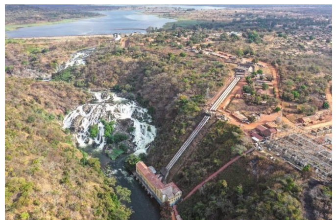
Wasserkraftwerk Mwadingusha © Andritz Hydro
