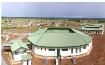
Hôpital de District de Sogakope, Ghana © VAMED
