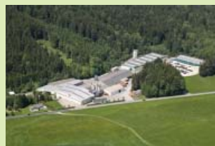
Neuhofer Holz GmbH, headquarter in Zell am Moos/AUT. Neuhofer Holz GmbH, Firmenhauptsitz in Zell am Moos/AUT.
